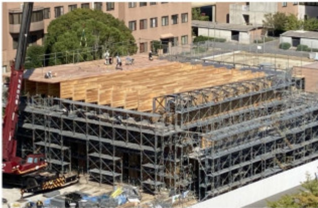
岡山大学 共創共創コモンズ建設状況
