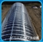
工場・倉庫設置
