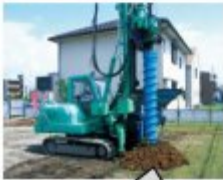
従来（3m掘削時） 残土が発生
